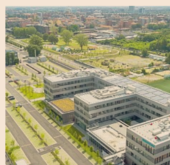
Casa Siemens. Orti e sede dall'alto
